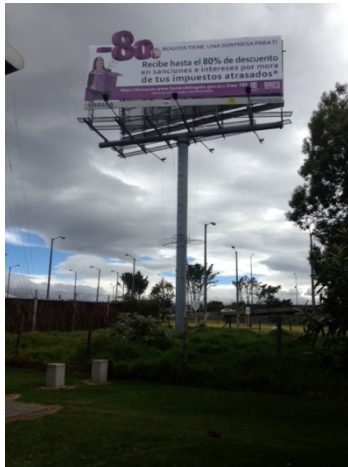
VISTA PANORÁMICA DEL ELEMENTO INSTALADO – SENTIDO N-S
